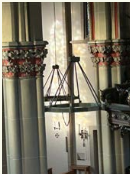
Zwei Infrarotstrahler hängen zum Test provisorisch in St. Johannes Baptist
